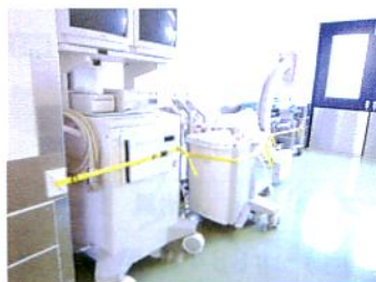
手術室周辺 機器走行防止対策
